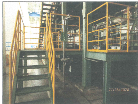
ภาพที่ 2.2-20 ฝักบัวล้างตัวและอ่างล้างตาฉุกเฉิน
