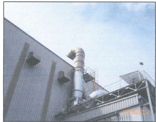
ภาพที่ 2.2-2 ระบบบำบัดอากาศแบบ Selective Catalytic Reduction (SCR)
